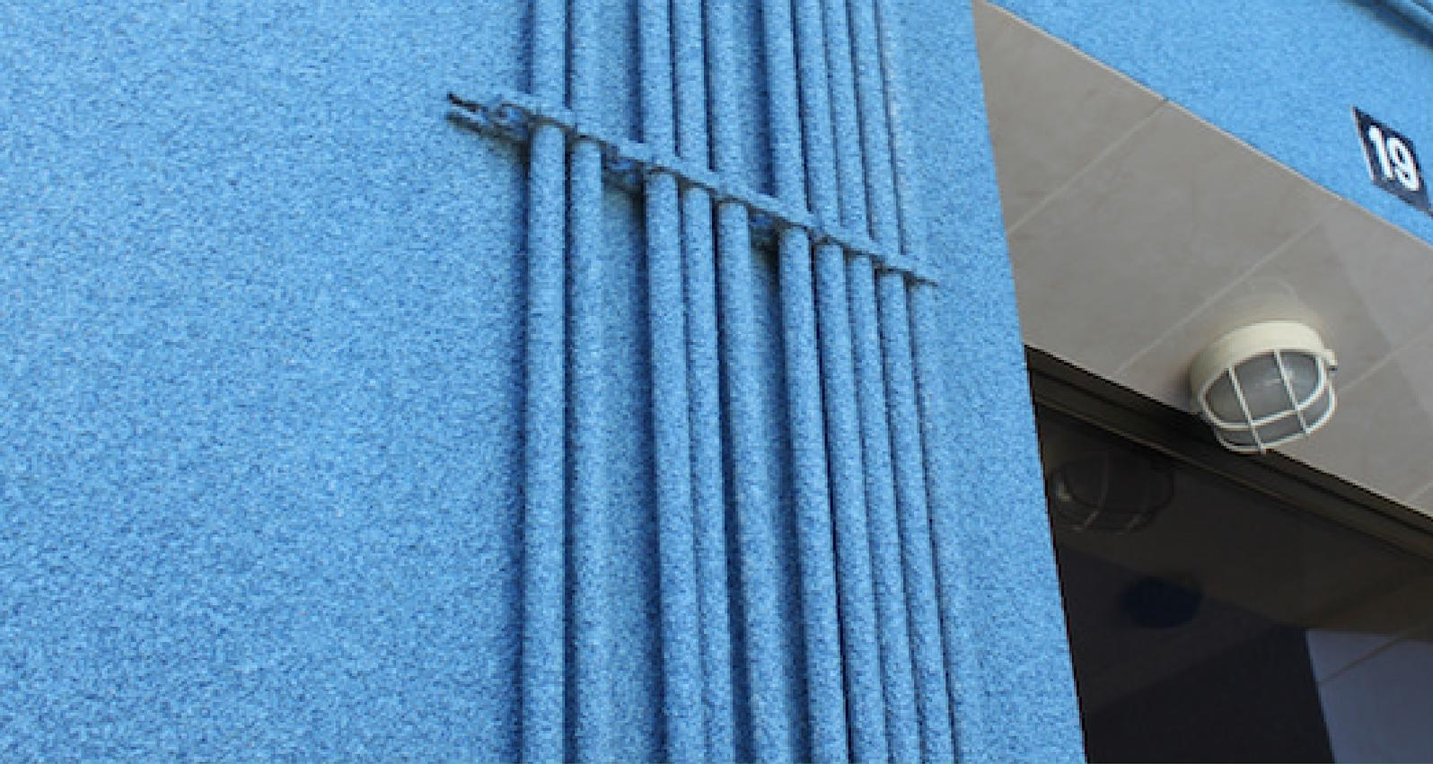
El sistema SISTEMA STONE VIPEQ es un RECUBRIMIENTO COLOREADO DE ALTA DUREZA CON PARTICULAS DE CUARZO.
