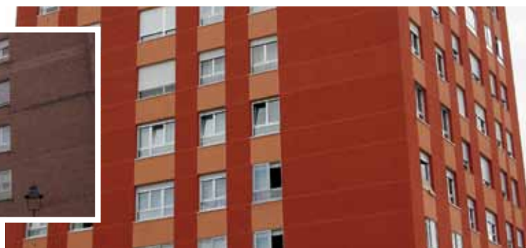
Rehabilitado con sistema Granocryl
