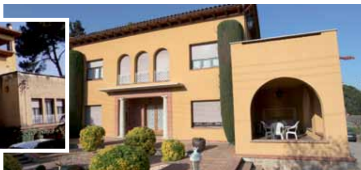
Rehabilitado con sistema Granocryl
