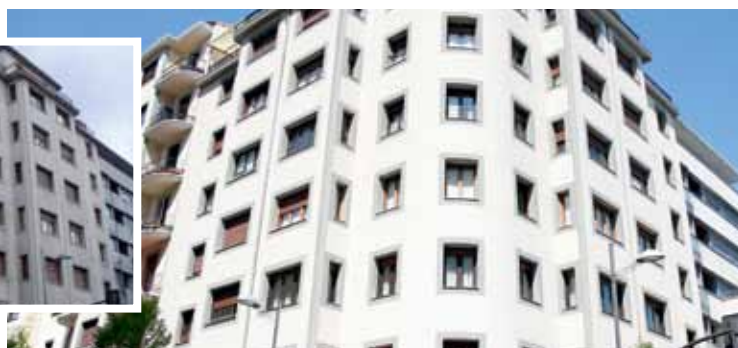
Rehabilitado con sistema Granocryl
