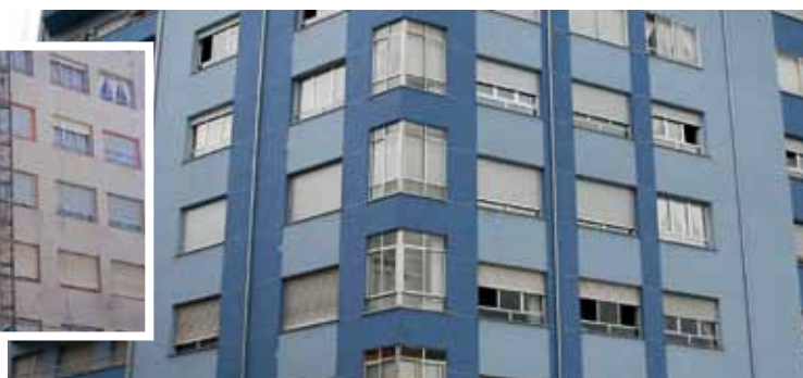
Rehabilitado con sistema Granocryl
