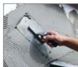
Previo a la realización de la capa de regularización, deben reforzarse zonas como cantos de huecos en puertas y ventanas, mediante la colocación de malla de fibra de vidrio tratada antiálcalis directamente sobre las placas de aislamiento, utilizando **weber.therm base**.
