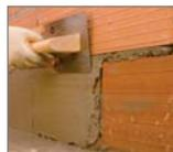
En caso que se pretenda revestir la cara inferior del perfil, la malla deberá encolarse directamente sobre el soporte antes de la aplicación del perfil para, posteriormente, doblarse sobre el aislamiento.
