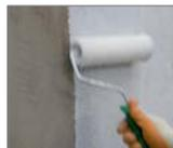
Como paso previo a la realización del acabado acrílico, aplicar mediante rodillo el regulador de fondo **weber CS** para uniformizar el grado de absorción del soporte y mejorar la homogeneidad de la coloración final.
