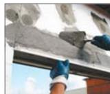
En ventanas es recomendable la colocación de un perfil de goterón con red. De este modo se refuerza la arista, a la vez que se evita la escorrentía de agua por la fachada.
