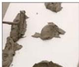
Sobre soportes de albañilería o mampostería aplicar un cordón de 2-4 cm de espesor de mortero polimérico, a lo largo del perímetro de la placa y tres puntos del mismo material en el centro.
