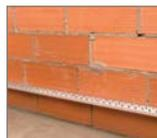
El sistema debe ser limitado en su contorno inferior por un perfil de arranque de aluminio de anchura adaptada al espesor de las placas que se prevea utilizar. Dicho perfil facilita el arranque del montaje del sistema garantizando su horizontalidad y protege al mismo ante la penetración de humedades u otras agresiones externas.
