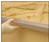
Reglear hasta conseguir una superficie plana, estable y homogénea hasta conseguir el espesor deseado. Previamente se habrán colocado las reglas metálicas para delimitar las superficies a proyectar y determinar el espesor (máximo de 60 mm).
