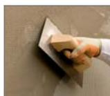
Tras el secado de la primera capa, aplicar de nuevo **weber.therm base** hasta conseguir un espesor total final aproximado de 5 mm, envolviendo completamente la armadura. La superficie conseguida debe ser plana, sin marcas y con una textura constante en toda su extensión.
