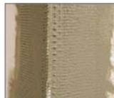
Las **aristas del sistema** en esquinas y contornos deberán ser reforzadas mediante un perfil de esquina con red, de aluminio o PVC. El perfil será colocado directamente sobre la placa de aislamiento con el mismo mortero polimérico.
