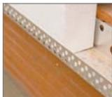
El montaje del sistema debe realizarse desde la parte inferior hacia la superior, partiendo del perfil de arranque colocado a una distancia aproximada del suelo de 15 cm, apoyando cada hilada de placas de aislamiento sobre la anterior.
