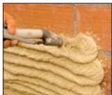
Amasar el mortero termoaislante **weber.therm aislone** mecánicamente con 8,5-9,5 l de agua limpia por saco, y aplicar de forma manual o por proyección mecánica.
