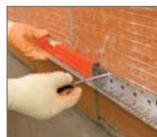
Para su fijación deben utilizarse tornillos y tacos adecuados, con una distancia entre ellos inferior a 30 cm y, entre perfiles, debe dejarse un espacio entre 2 y 3 mm para permitir su dilatación.
