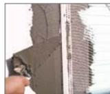
Las **juntas de dilatación** deben ser respetadas interrumpiendo el sistema y utilizando un perfil de junta de dilatación aplicado sobre las placas de aislamiento.
