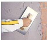
Los soportes deben ser planos, estar exentos de irregularidades y defectos de planimetría. De no ser así, la superficie debe ser regularizada mediante la utilización de un mortero de regularización (**weber.therm base** o **weber.cal basic**).
