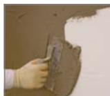
El revestimiento de las placas se realizará mediante la aplicación a dos manos del mortero polimérico de altas prestaciones **weber.therm base**, incorporando una armadura de fibra de vidrio con tratamiento anti-álcalis. La colocación de la malla de fibra de vidrio debe realizarse sobre la primera capa de producto cuando ésta se encuentra todavía fresca, y no debe colocarse nunca directamente sobre la placa aislante.
