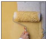
Sobre hormigón liso o soportes sin absorción, aplicar el puente de unión **weber.FX** como paso previo a la aplicación de **weber.therm aislone**.
