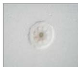
Los pequeños salientes resultantes de la colocación del taco deben taparse con el propio mortero **weber.therm base** como paso previo al revestimiento de las placas.
