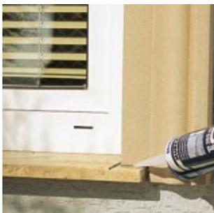
Las conexiones de los perfiles para fachadas con elementos constructivos como por ejemplo, un alféizar, cubrimientos o elementos de madera, de debe rellenar con pegamento elástico.
