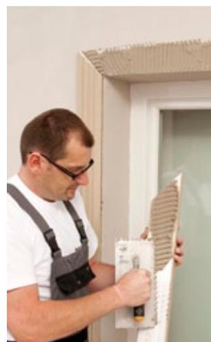
El encolado se realiza con un adhesivo homologado, Baunit StarContact. El adhesivo debe extenderse en toda la superficie del perfil y en la base con una llana dentada. Perfiles de gran peso deben ser apuntalados.
