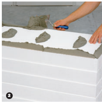
2 Fijación: Aplicar Baunit StarContact (mortero adhesivo), con una superficie mínima de un 40%.
