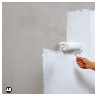
10 Baunit UniPrimer: Aplique una capa de imprimación como puente de unión entre mortero y revoco.
