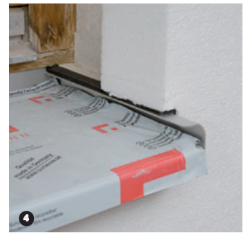
4 Sellado de uniones: Con cinta para juntas elástica (Fugendichtband).
