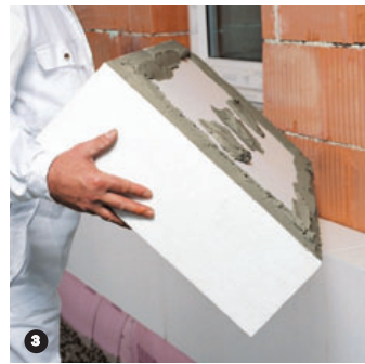
3 Alternativa Encolado: Aplicar el mortero adhesivo en la pared (espesor de borde 1,5 cm; distancia del borde máx. 10 cm, contacto adhesivo mín. 60%).
