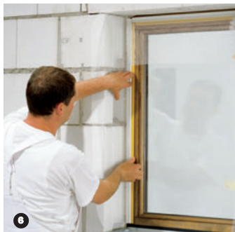
6 Sellado de ventanas: Perfil de conexión de ventanas para evitar puentes térmicos.
