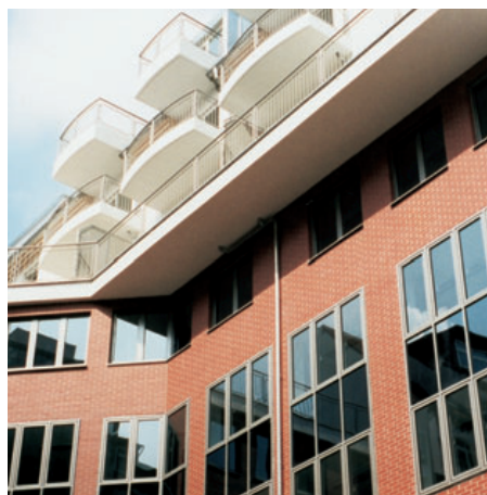
Combinado con revestimiento aislante de lana mineral, Baunit CeramicSystem se considera un sistema no inflamable y por lo tanto no está sujeto a limitaciones en cuanto a la altura del edificio.
