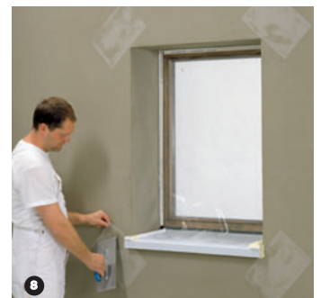
8 Armadura en diagonal - Malla de fibra en diagonal: Colocar una pieza de malla de 30 x 40 cm diagonal en las esquinas de ventanas y puertas.
