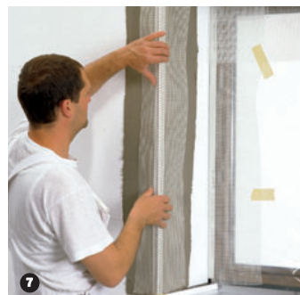
7 Perfil de esquina: Perfil de escuadra con malla de fibra de vidrio para proteger de impactos.
