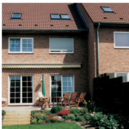
Las piezas cerámicas protegen el aislamiento y mejoran la estética del edificio.
