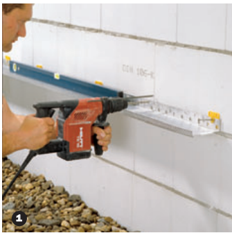
1 Perfil de arranque: Nivelar y fijar con set de montaje.
