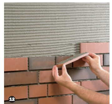
12 Alternativa - Acabado con el revestimiento CeramicSystem: Instalar piezas cerámicas.
