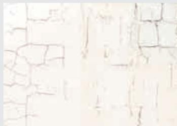
Rehabilitación de soportes microfisurados (hasta 1 mm).
